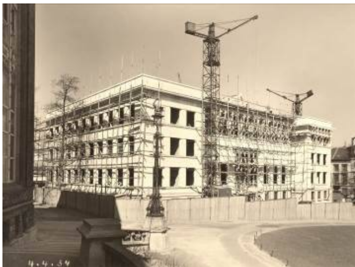
1. ábra – Az Eastman Intézet építése, 1934.
