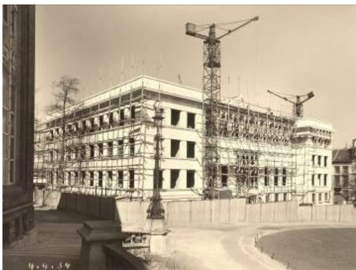
Figura 1 – Costruzione dell'Istituto Eastman, 1934.
