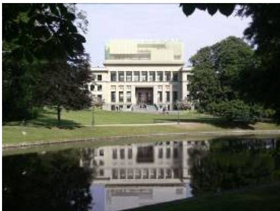
Fuente: Atelier d'architecture Chaix & Morel et Associés, París; JSWD, Colonia; Imagen: © E. Young / AACMA - JSWD
