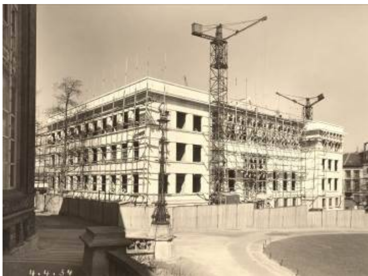
Imagen 1 – Construcción del edificio Eastman, 1934.
