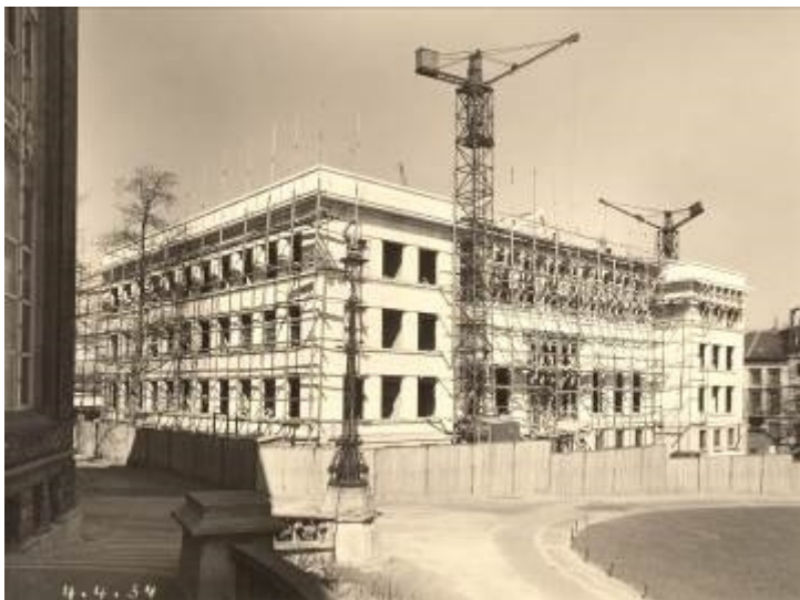
1. attēls. Īstmena institūta būvniecība, 1934. gads.
