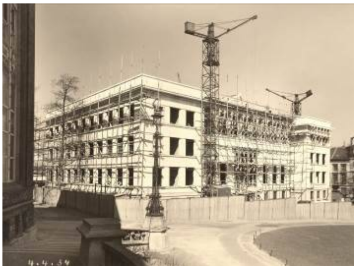
Figura 1 — Construção do Instituto Eastman, 1934.
