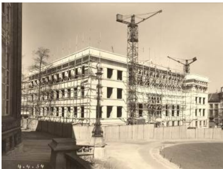
Slika 1 – Gradnja Eastmanovega inštituta, 1934
